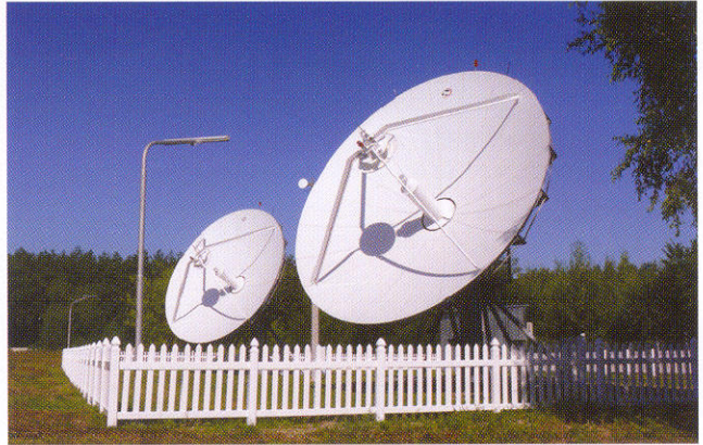
Антенний комплекс системи супутникового радіочастотного моніторингу
